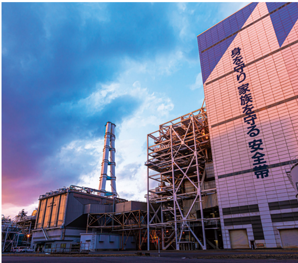
2023年度にアンモニアの実機実証試験の開始を予定している碧南火力発電所（愛知県碧南市）。現場では、安全を最優先に安全帯（墜落抑止用具）などの装着を徹底している。
